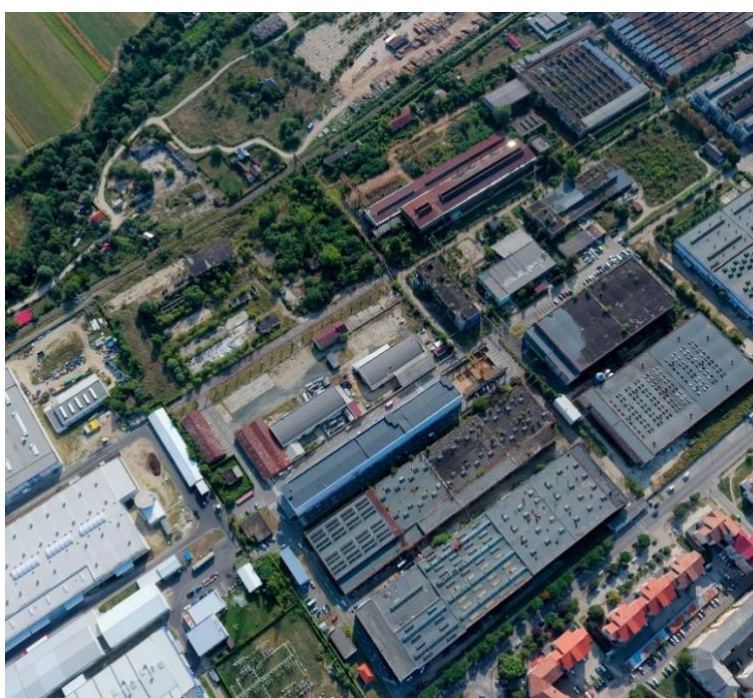
Imaginea 45. Vedere aeriană din Parcul industrial Cugir
